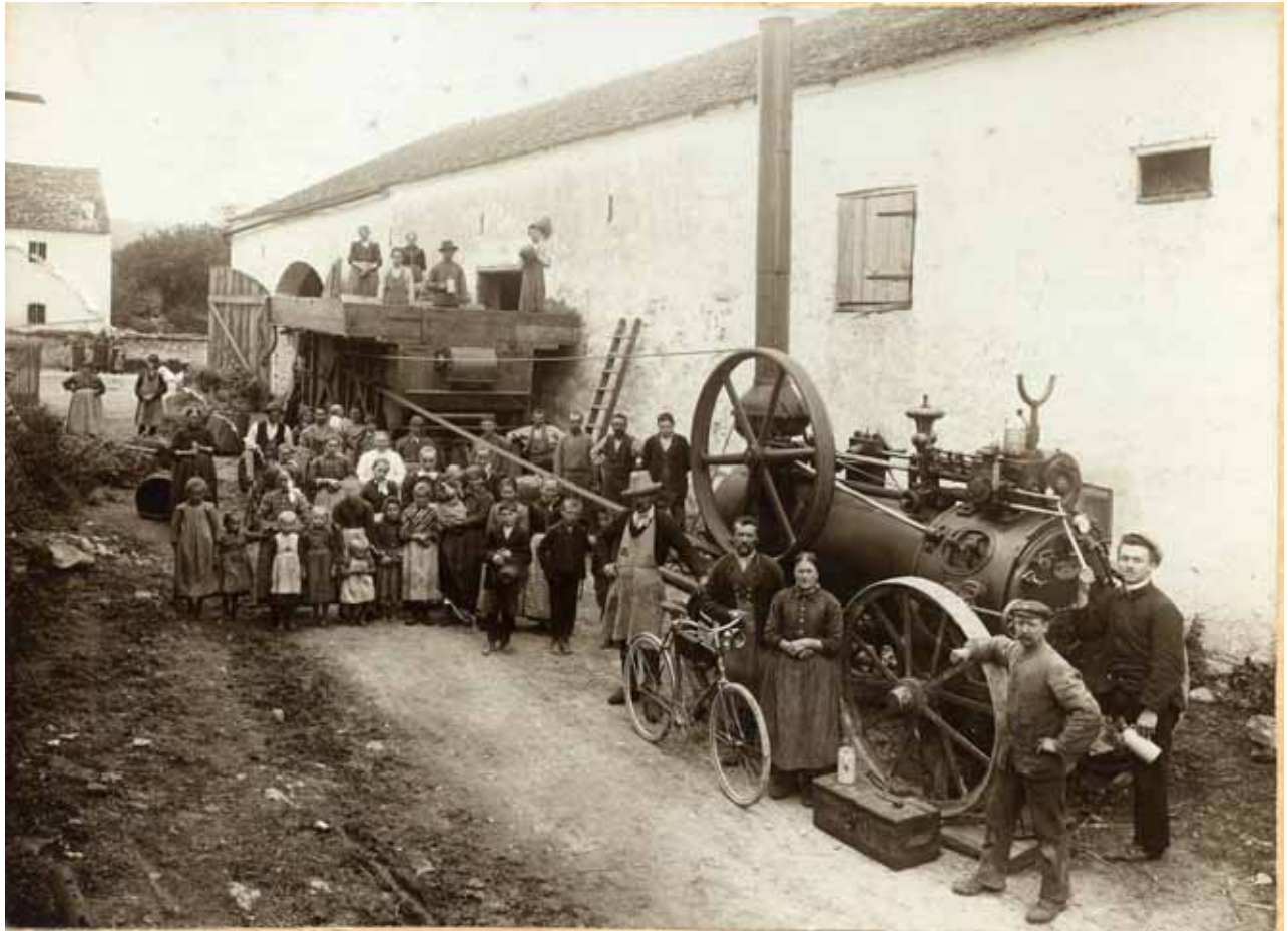
Dreschen mit der Lokomobile in Meilenhofen, Lkr. Eichstätt, um 1909.
